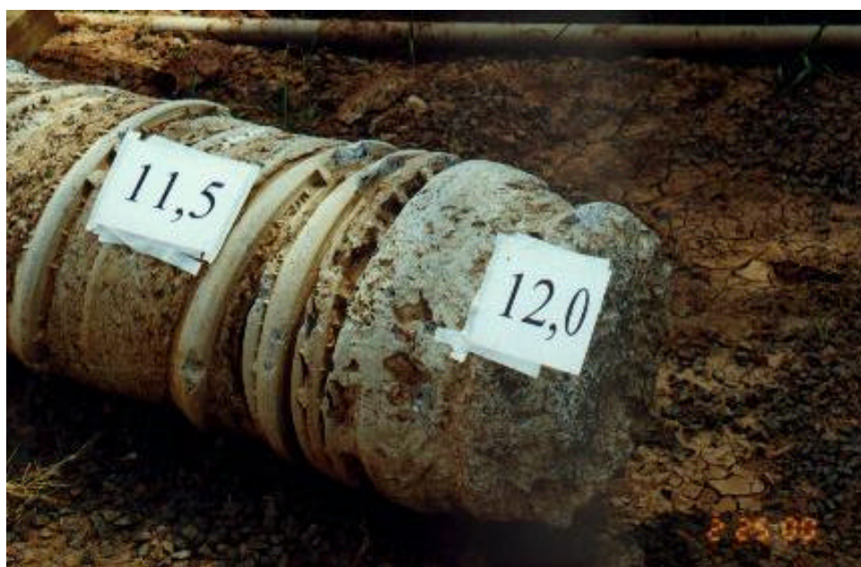
Foto 4.13 - Estaca ômega 2 – ponta.
