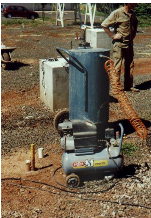
Foto 4.4 – Equipamentos utilizados na injeção da nata de cimento.
