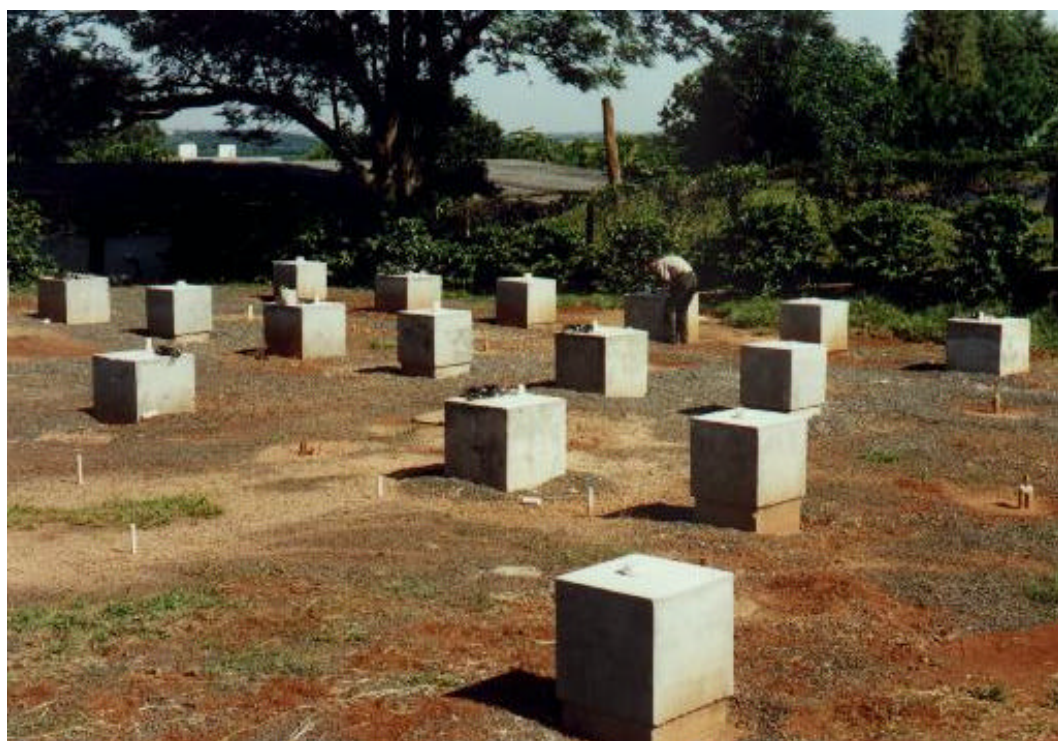
Foto 4.3 - Vista geral dos blocos de coroamento das estacas.
