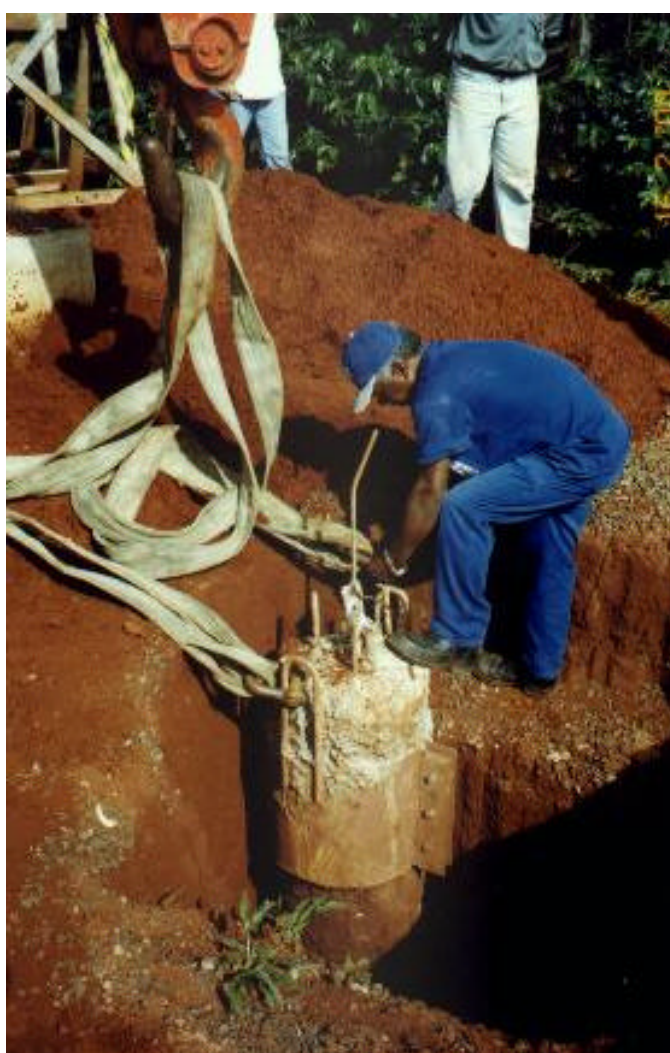
Foto 4.8 - Fixação dos cabos do guindaste.
