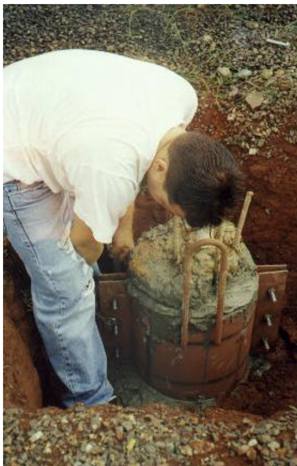
Foto 4.7 – Fixação do anel metálico à estaca.
