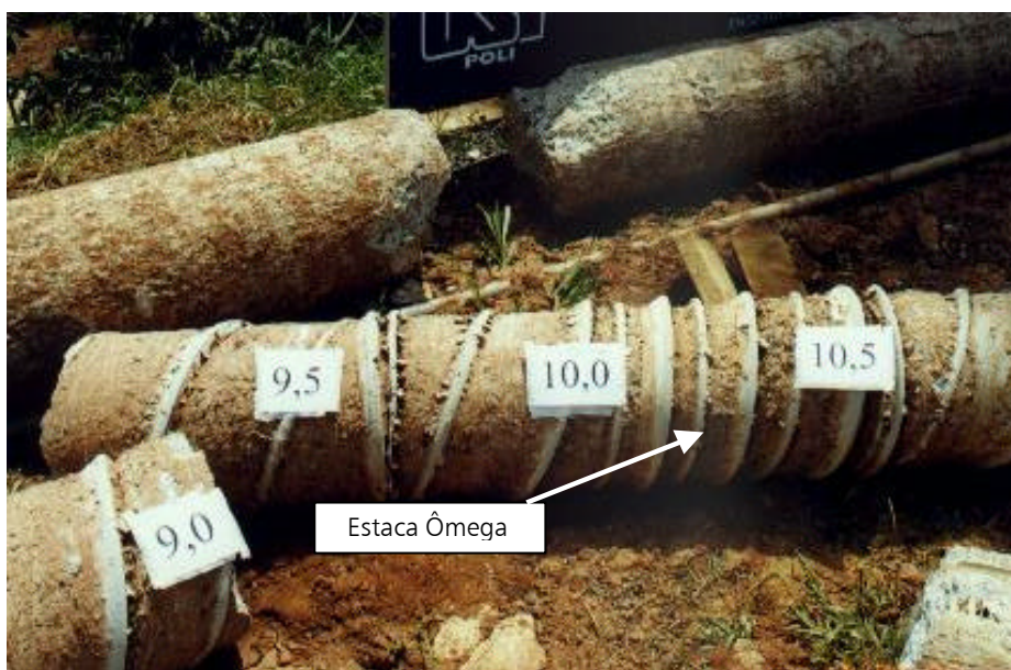
Foto 4.11 - Estaca ômega no trecho de 9,0 a 10,5m de profundidade.
