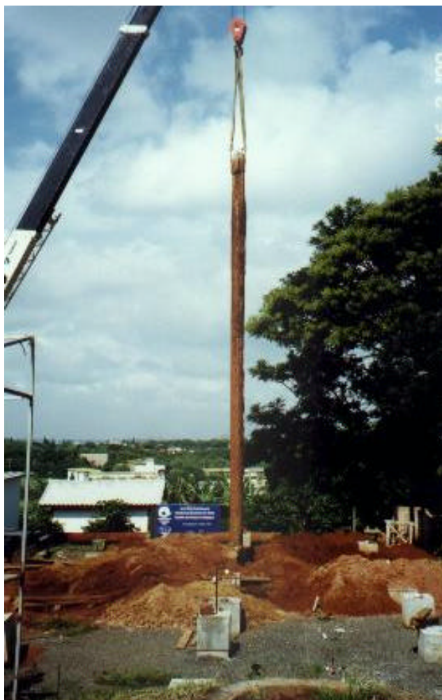
Foto 4.9 - Extração da estaca hélice contínua 2.
