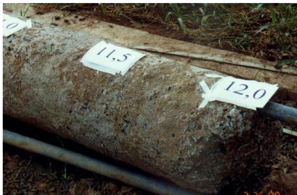
Foto 4.15 - Estaca escavada 1 – ponta.
