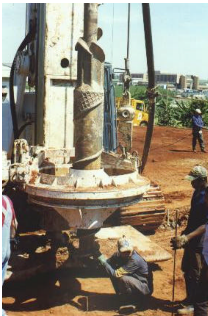
Foto 4.1 – Posicionamento do equipamento para o início de execução da estaca ômega.
