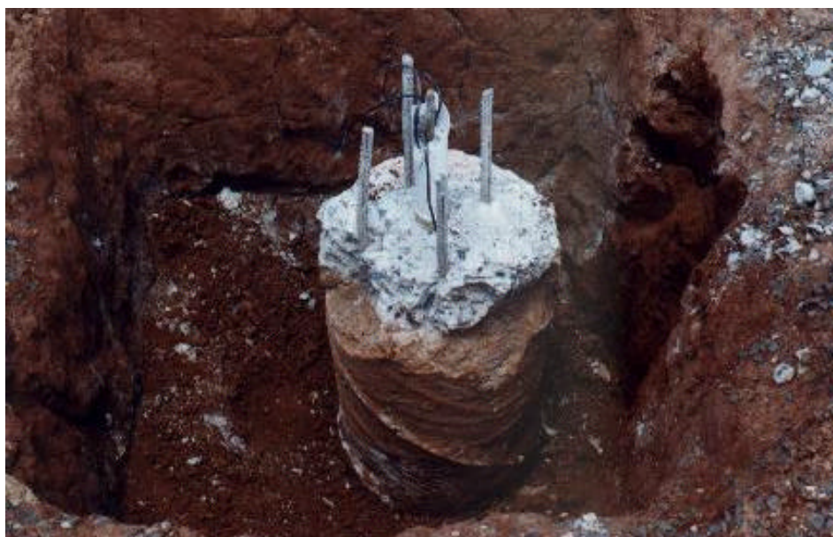
Foto 4.5 – Topo da estaca ômega após a retirada do bloco.
