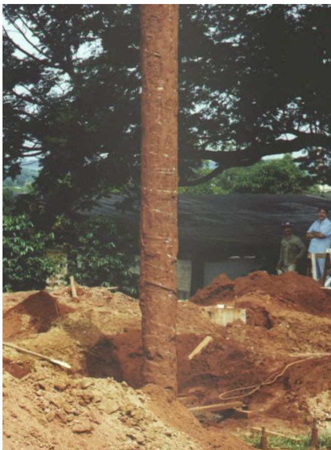
Foto 4.12 – Aderência do solo na estaca ômega 2.
